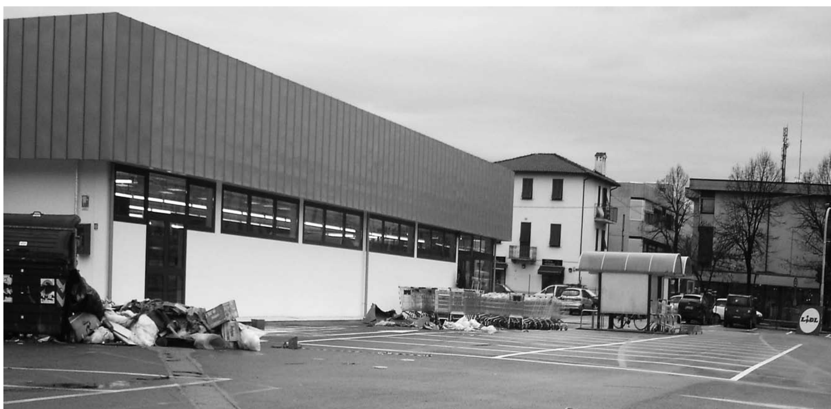
La filiale Lidl di Lucca durante la ristrutturazione
