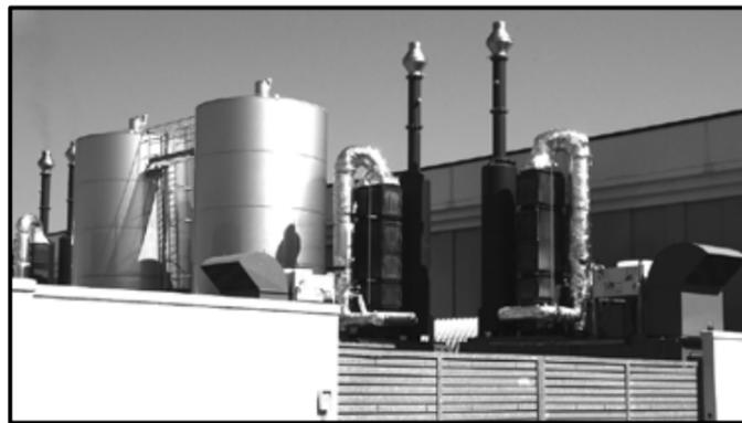
Due impianti a biomasse (ad oli vegetali) per la produzione di energia da fonti rinnovabili di potenza termica immessa complessiva di 1,2 MW/t ca. e potenza elettrica generata dell'ordine di 500 kW/e. Gli impianti sono attivi da luglio. Inquinanti previsti: Polveri, CO, NOx, Composti Organici Volatili, NH<sub>3</sub>.
