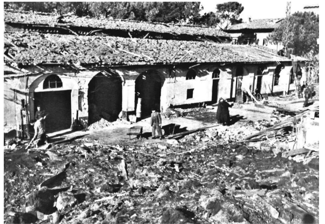
Copia di foto del gennaio 1944 in cui si vedono le distruzioni ad opera degli ordigni nell'area Gesam, interessato dallo sbancamento. (Fonte: AA. VV. Officine del gas di Lucca, 2004).
