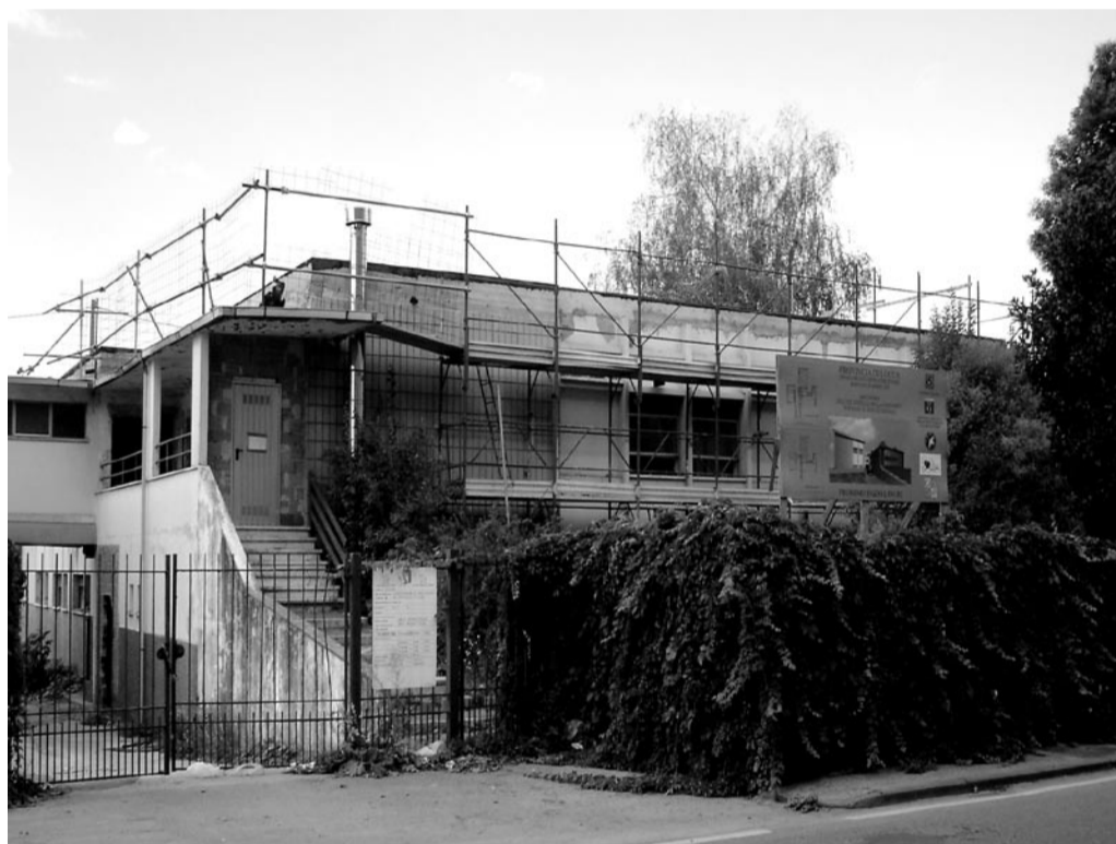
Il cantiere dell'ex-ostello, sarà bene comune?
