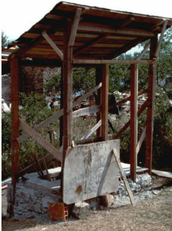
Gabinetto esterno a doppia camera tipo vietnamita realizzato a Granara: segatura e cenere in aggiunta, urine prevalentemente nei campi
