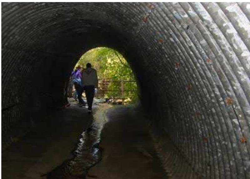
La sezione del canale è stata recentemente ridotta per rinforzare la struttura portante, ma la sua durata è comunque limitata nel tempo e l'ENI non vuole assicurare la manutenzione futura degli impianti, pur avendo ottenuto l'autorizzazione al tombamento con vincoli di transitorietà e di manutenzione.
